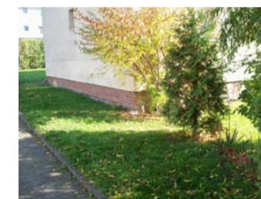
RR Hs 19 Schadstelle Wurzeln vor Haus
